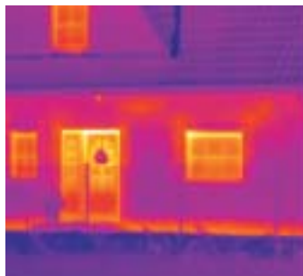
Pérdidas de calor en puertas y ventanas
