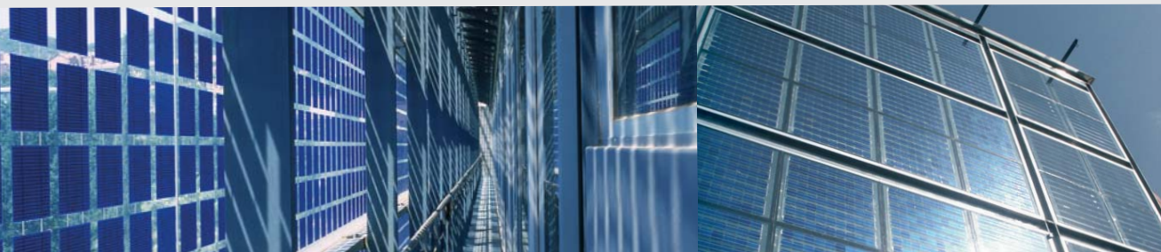
Edificio La Salle Barcelona (España) Detalle fachada doble piel Sistema Reynaers: CW 50-HL con paneles fotovoltaicos
