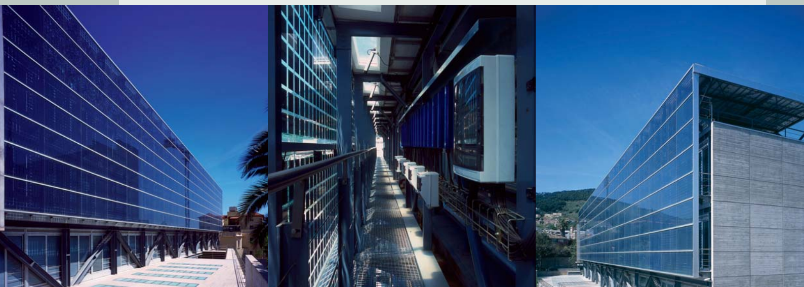
Muro cortina con paneles fotovoltaicos - La Salle - Barcelona, España (Arquitectos: Robert y Esteve Terradas Muntañola)
