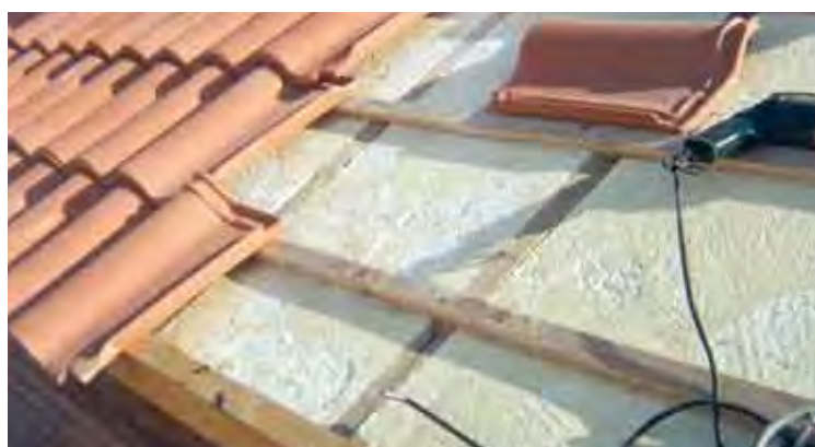
Rehabilitación en cubierta inclinada
