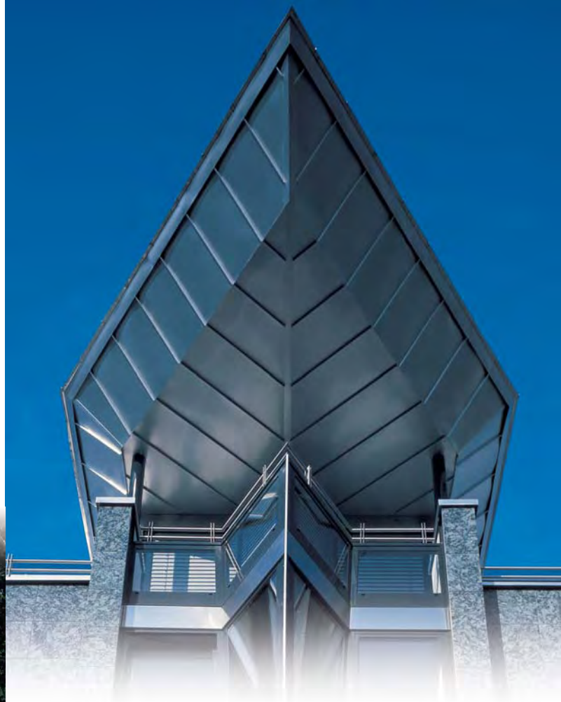
Edificio de oficinas en Hofheim, Alemania. 320 m 2 , Klarlack.
