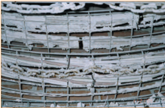
Figura 3: La instalación al finalizar el ensayo y alcanzados los 1.000°C.
