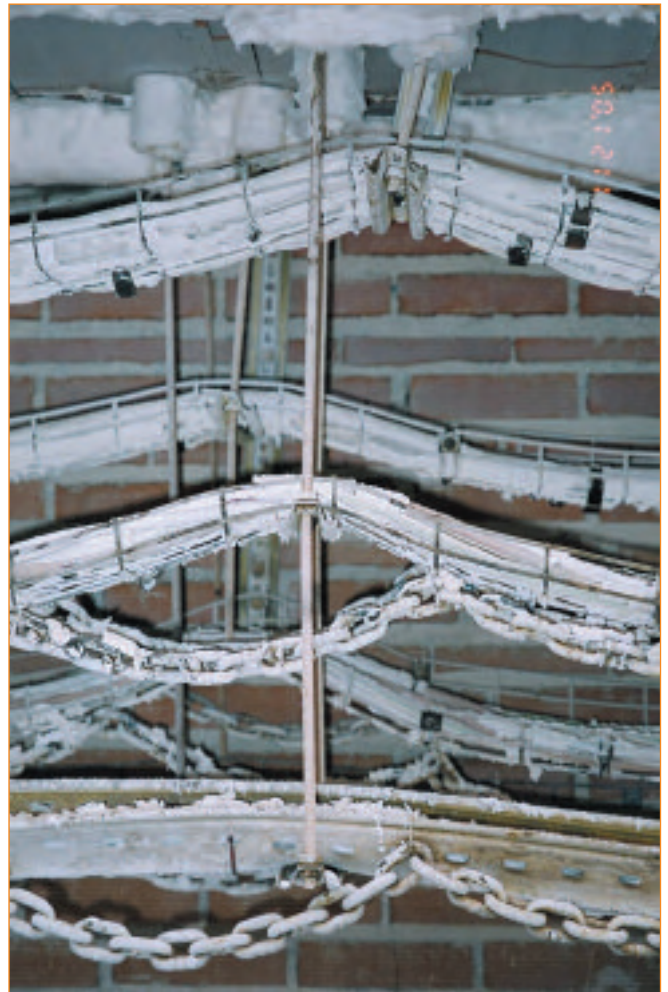
Figura 4: Detalle de la Rejiband y los cables finalizado el ensayo.
