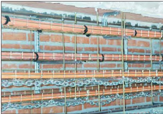
Figura 1. Vista general del montaje
