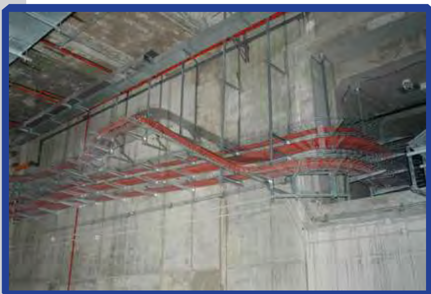
Instalación de bandeja Rejiband con estructuras metálicas.
