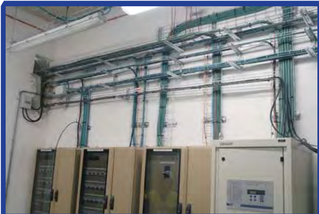
Instalación de Bandeja Rejiband en sala de mando y distribución.
