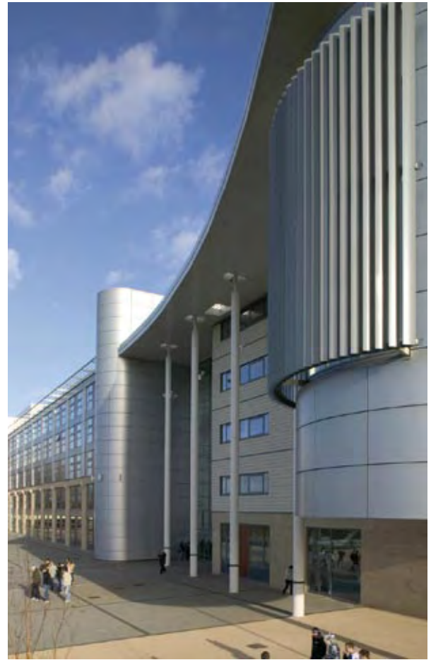
Lama Icarus 300 en vertical con sistema Quickfix en edificio corporativo de empresa.
