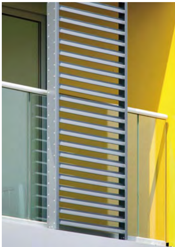
Detalle Sunclips caset con cuerpo corredero en balcón edificio viviendas.
