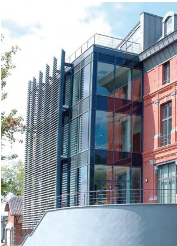
Instalación Sunclips vertical en edificio público.
