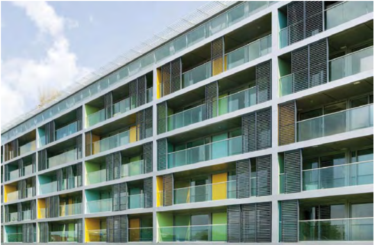
Edificio viviendas con protección solar Sunclips caset.
