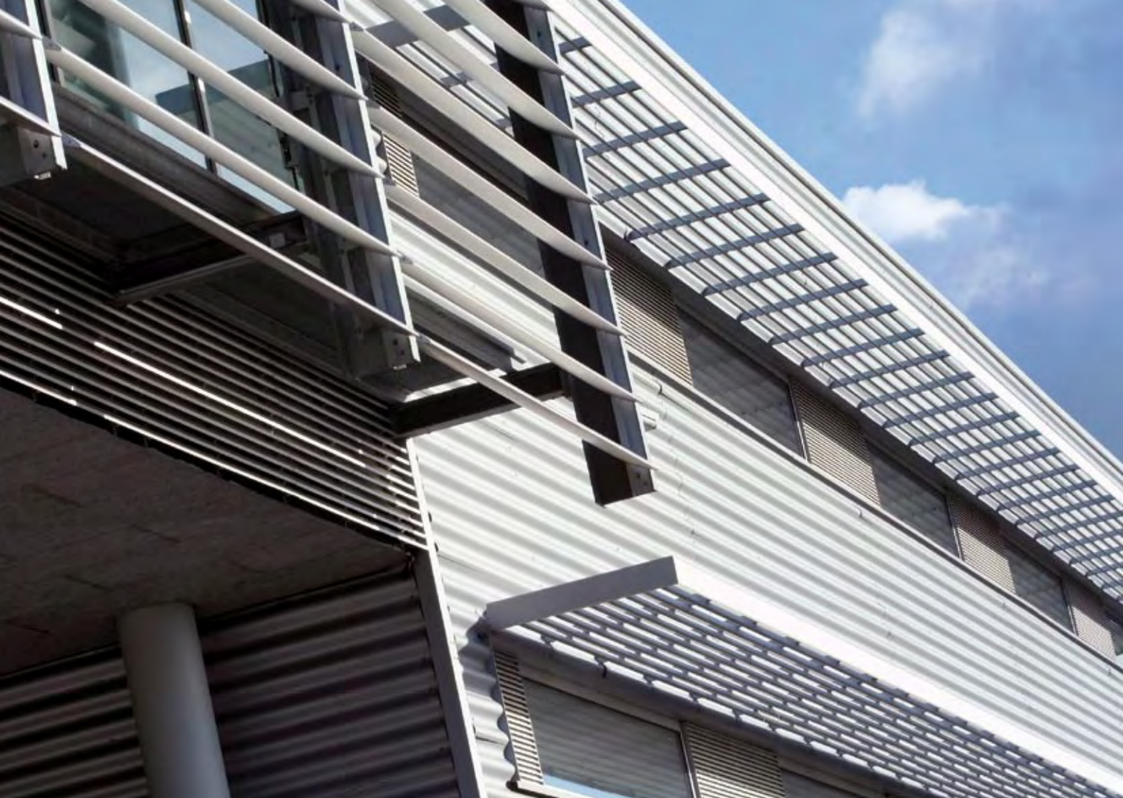
Edificio corporativo empresa privada con instalación Icarus fijo.
