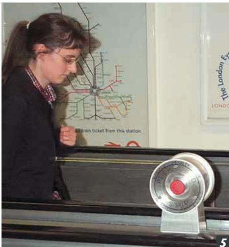
Pulsador de parada de emergencia
