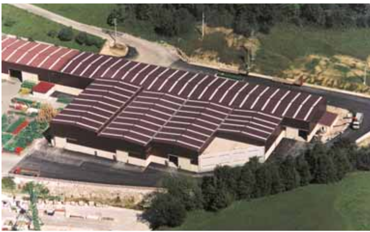
GRUAS JASO. Idiazábal (Guipuzkoa) Instalador: SICESAL. DP10 hielo 1800m 2
