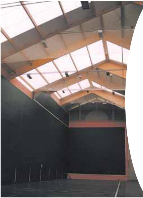
FRONTON de Orozko (Vizcaya). Inst: Lanik, S.A. Material: DP 16 opal. 1500m 2
