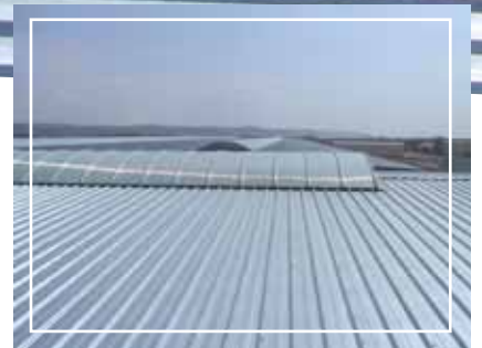
Instalación de CURBIMETAL .Alagón(Zaragoza)
