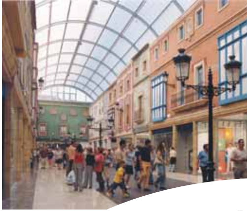
CENTRO COMERCIAL Parque Astur. Instalador: Hiasa
