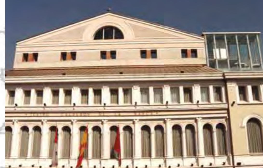
TEATRO CALDERON - VALLADOLID U.T.E.: FOMENTO CONSTRUCCIONES Y CONTRATAS - FCC CONSTRUCCION
