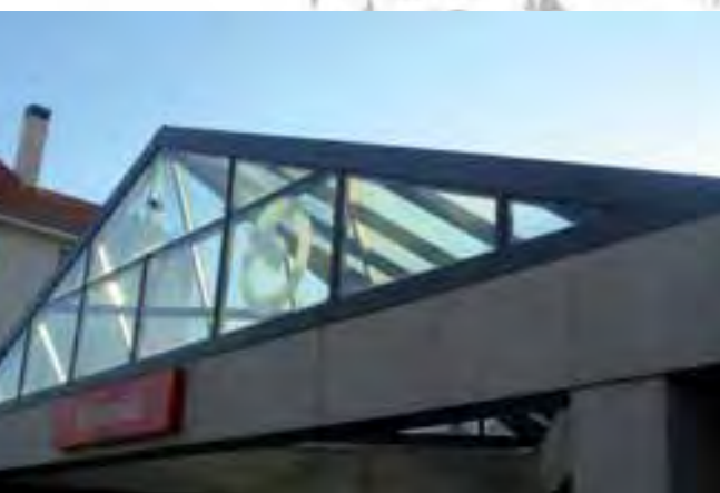
ESTACION EL ESCORIAL ACCIONA
