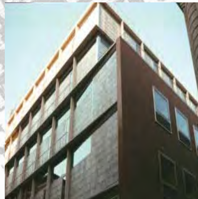
EDIFICIO ADMINISTRATIVO COMUNIDAD DE MADRID. C/ CARRETAS, 4 FCC, S.A. ARQº: FRECHILLA & LOPEZ PELAEZ
