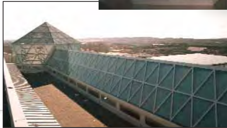
CENTRO COMERCIAL EL MIRADOR. CUENCA Lucernario en forma de icosaedro regular (20 lados) unido a otro de dos aguas, que aportan luz cenital al mall central del centro comercial.
