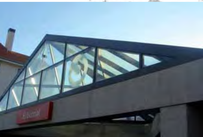
ESTACION EL ESCORIAL ACCIONA
