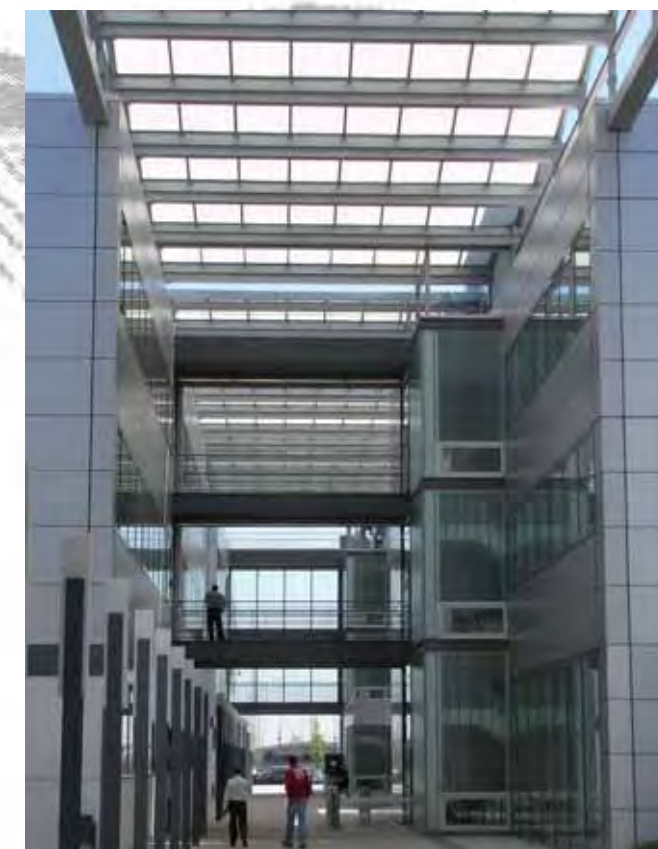
SEDE SOCIAL SIEMENS - GETAFE - MADRID INGENIERIA: MACE ARQº.: JULIO TOUZA Y ASOCIADOS, S.L.
