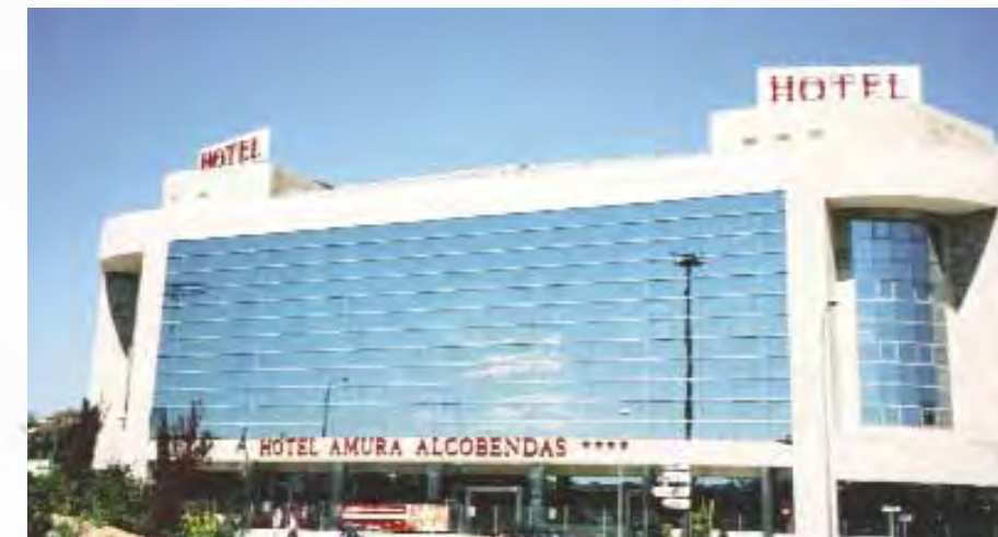
HOTEL AMURA - ALCOBENDAS - MADRID TILMON ESPAÑA, S.A. ARQº.: D. AMBROSIO ARROYO / D. JERONIMO ARROYO
