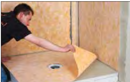
18 Colocación del manguito impermeable Schlüter®-KERDI ...
