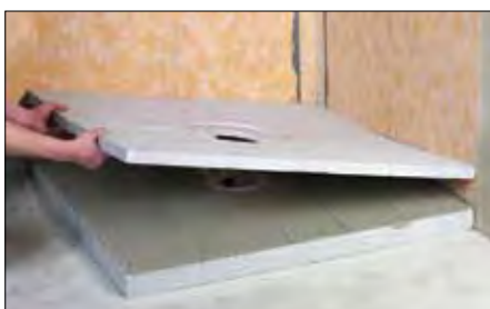
12b ... y colocación sobre el panel de compensación. (Atención: La junta de unión del panel de pendiente no se debe colocar encima de la tubería).
