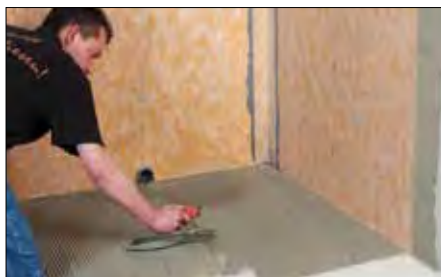
5 Aplicar el adhesivo en capa fina sobre el soporte plano.
