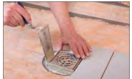
22 Se ajusta la rejilla de acero inoxidable a la altura de la cerámica y se rellena por debajo con adhesivo.
