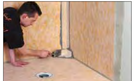
20 a Las piezas especiales de ángulos se colocan con Schlüter®-KERDI-COLL.
