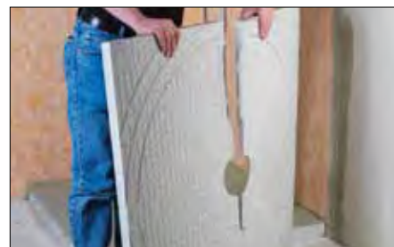
12a Montaje del panel de pendiente ...
