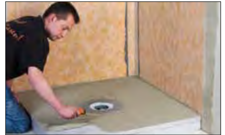
17 Sobre la superficie restante se aplica un adhesivo en capa fina con una llana de dentada de 3 x 3 mm ó 4 x 4 mm.
