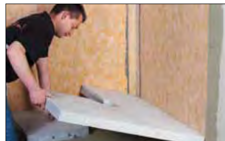
6 Colocación del panel de compensación. Observación: Consulte la ficha técnica 8.6 para mayor información sobre aislamientos acústicos.
