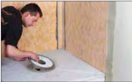
15 Presionar el elemento de desagüe en la salida y en el adhesivo.
