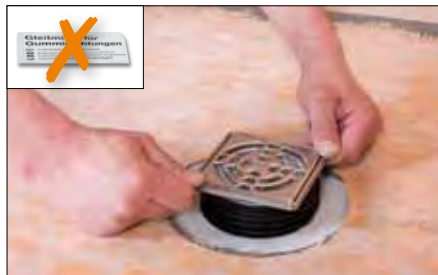
21 La rejilla de acero inoxidable con salida se presiona en el elemento de desagüe.
