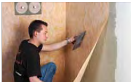
2 Colocación y alisamiento de la lámina Schlüter®-KERDI.
