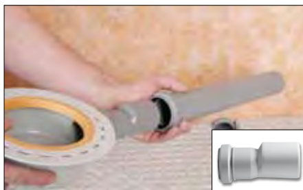
8 Unir la tubería con la salida de desagüe Schlüter®-KERDI-DRAIN. En caso necesario se puede emplear la reducción que contiene el set completo y...
