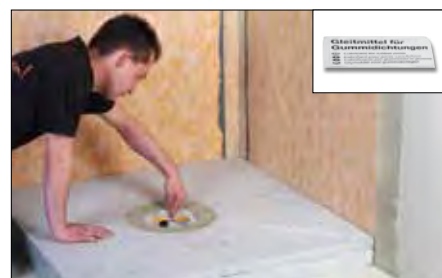
14 Lubrificar la falda de obturación en la salida de desagüe.
