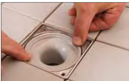
23 Antes de la puesta en marcha se debe desenroscar la rejilla de acero inoxidable y comprobar el correcto posicionamiento del sifón (en caso necesario se debe lubricar el anillo en forma de O).
