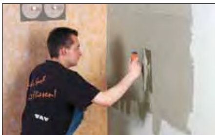
1 Aplicación del adhesivo en capa fina (con llana dentada de 3 x 3 mm) para la colocación de la lámina de impermeabilización Schlüter®-KERDI.
