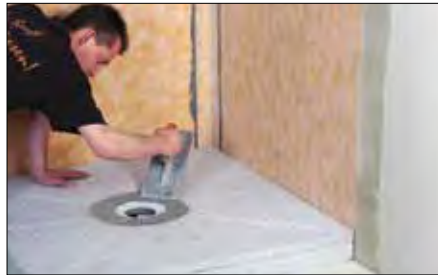
16 Aplicar Schlüter®-KERDI-COLL sobre el platillo del elemento de desagüe.
