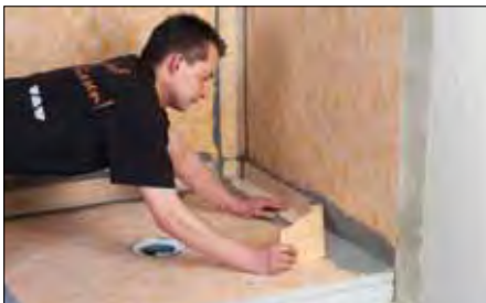
20 b También las entregas entre suelo y pared se impermeabilizan con la banda Schlüter®-KERDI-KEBA y Schlüter®-KERDI-COLL.
