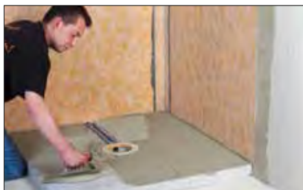
11 Aplicación del adhesivo en capa fina al panel de compensación.
