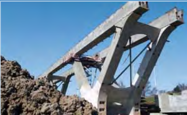
Viaducto entre Herve y Battice, Belgica
