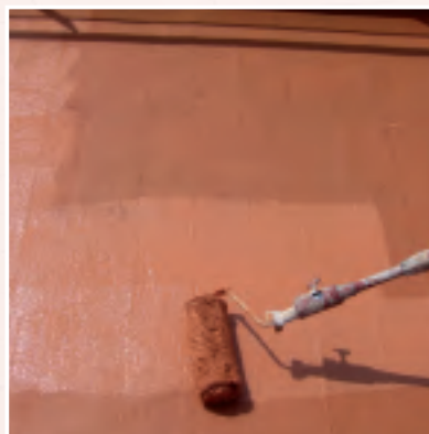
Aplicación de Aquaflex Roof medianterodillo de pelo largo
