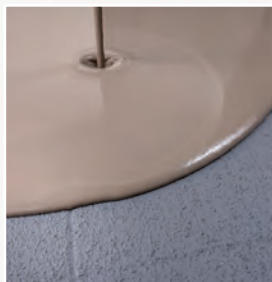
Aplicación de enlucido autonivelante Ultraplan sobre Eco Prim Grip seco y aplicado sobre un pavimento antiguo.
