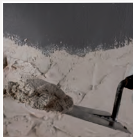
Aplicación de revoque sobre Eco Prim Grip.
