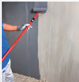
Aplicación de Eco Prim Grip con rodillo sobre soporte de hormigón.
