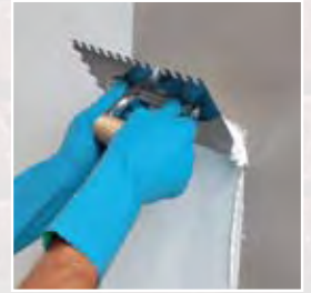
Aplicación de Fix & Grout Brick gris sobre el soporte
