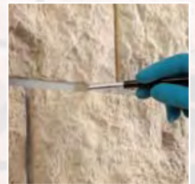
Alisado de las juntas con pincel húmedo
