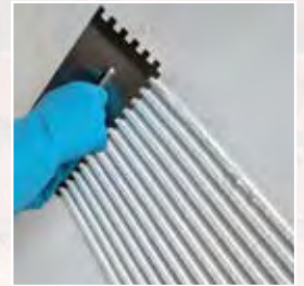
Aplicación de Fix & Grout Brick en diagonal con llana dentada n.10
