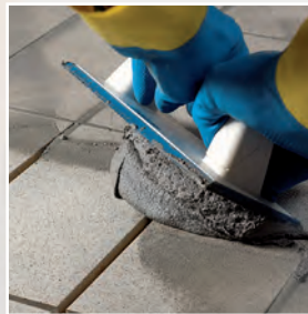
Aplicación de Kerapoxy CQ con llana Mapei
