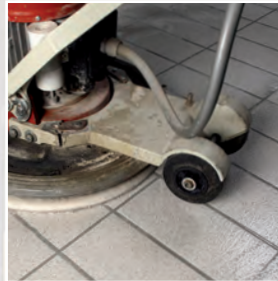
Limpieza con agua utilizando una máquina rotativa equipada con un disco de fieltro abrasivo, tipo Scotch-Brite®
