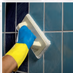
Kerapoxy CQ se emulsiona con agua, utilizando una esponja Scotch-Brite®
