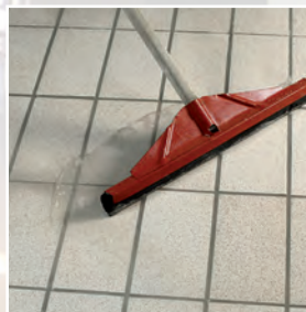
Eliminación del residuo líquido utilizando un rastrillo de goma
