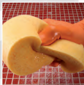
Mojado de la superficie rejuntada antes de la limpieza
