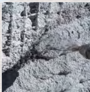
Aplicación de Mape-Antique Strutturale NHL
