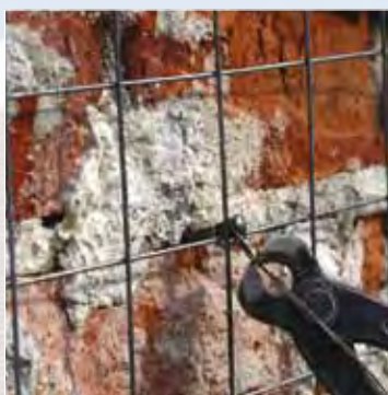
Fijación de una malla zincada al muro
