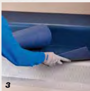
Colocación de PVC sobre escalones mediante el uso de Mapecontact
