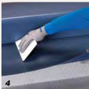
Masajeado del PVC tras su aplicación sobre Mapecontact
