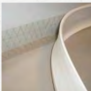
Colocación de zócalos de PVC plastificado mediante el uso de Mapecontact
