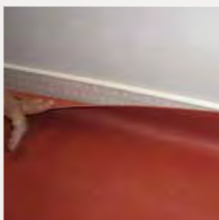
Colocación de media caña mediante el uso de Mapecontact
