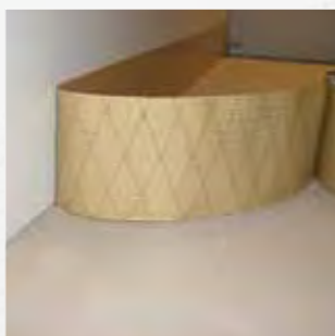
Colocación de zócalos de PVC plastificado mediante el uso de Mapecontact
