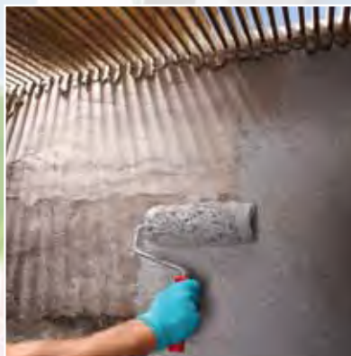
3. Aplicación de Mapelastic Foundation
