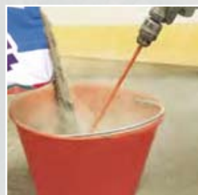
Mezcla con batidora de 4 a 4,5 l. de agua con 25 kg de Planex
