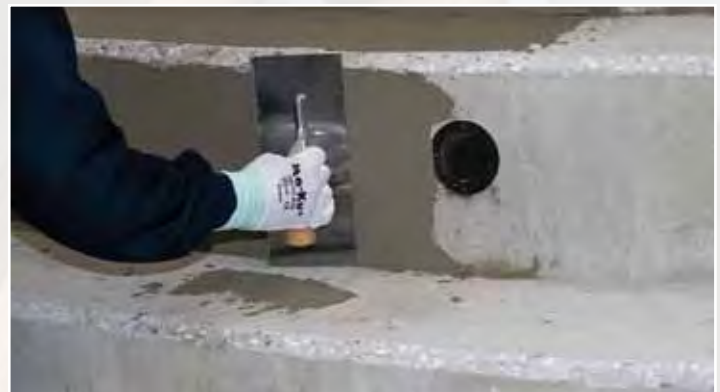
Enlucido de la contrahuella de un peldaño en la escalera de acceso a una piscina
