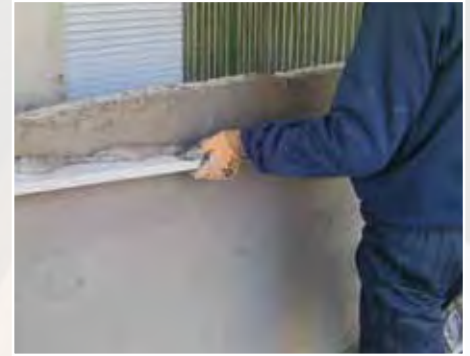
Regularización de la planitud mediante regla metálica
