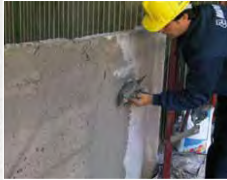
Nivelado de un antepecho de hormigón
