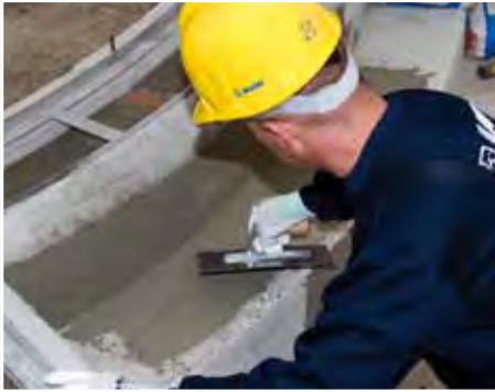
Regularización de la huella de un peldaño en la escalera de acceso a una piscina
