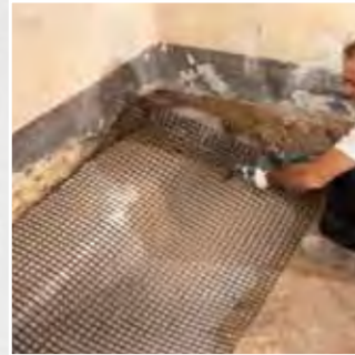
Posicionamiento de la malla de refuerzo de fibra de vidrio álcali-resistente Mapegrid G220
