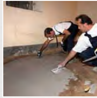
Aplicación a llana de la primera capa de Planitop HDM Restauro en el trasdós de una bóveda
