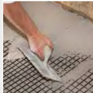
Aplicación a llana de la segunda capa de Planitop HDM Restauro en el trasdós de una bóveda, de forma que cubra de manera homogénea la malla Mapegrid G220
