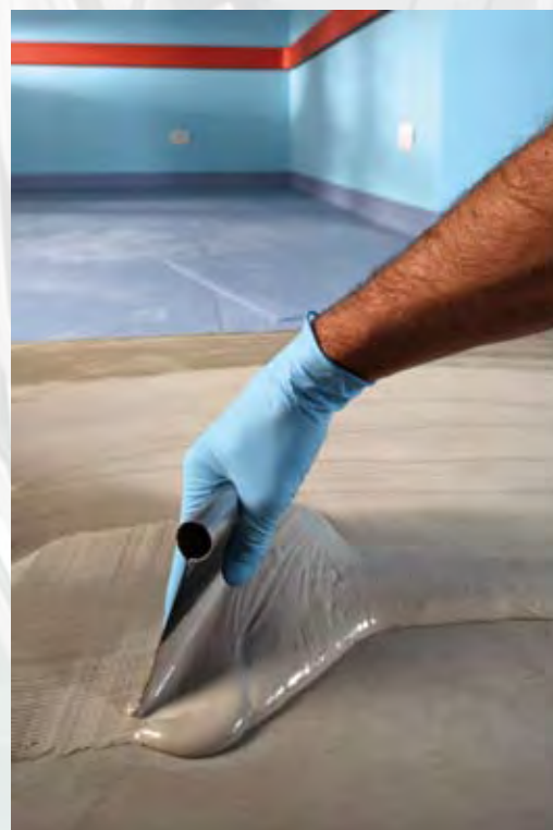
Aplicación de Ultrabond Eco 380 sobre el soporte con espátula dentada.
