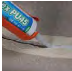
Grietas y fisuras
