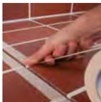
5. Encintar los bordes de la junta
