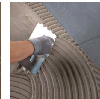
Aplicación del adhesivo en pavimento con llana de diente redondo de radio igual a 9 mm.
