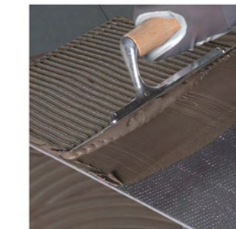
Aplicación de ULTRALITE S1 en el reverso de la baldosa
