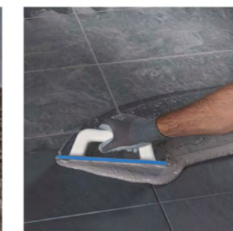
Rejuntado con llana de goma, con ULTRACOLOR PLUS
