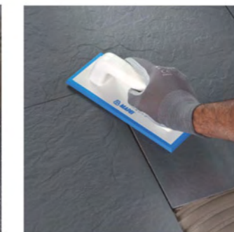
Colocación y presionado de la baldosa
