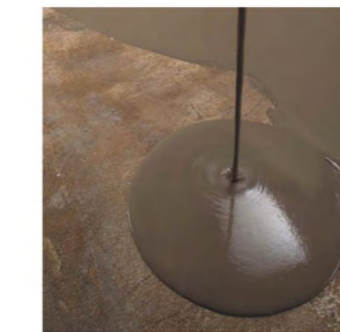
Nivelación del soporte con ULTRAPLAN
