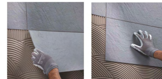
Aplicación de la baldosa en la pared
