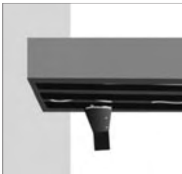
5. Una vez colocado el CARBOPLATE eliminar el exceso de resina con una espátula.
