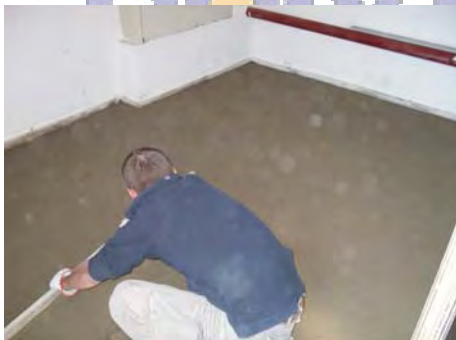
Terminar de rellenar con mortero.
