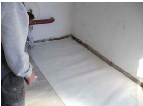
Extender Polynum BLH sobre forjado, existente lo mas limpio posible.
