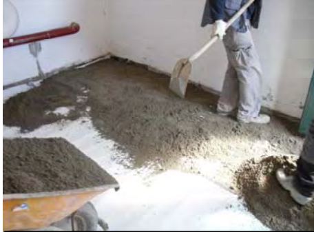
Poner sobre rejilla de mallazo sobre el mortero existente.
