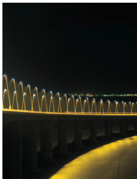
TAGE Puente Vasco de Gama – Lisboa Portugal
