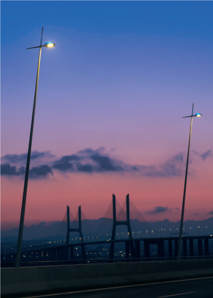
TAGE Puente Vasco de Gama – Lisboa Portugal
