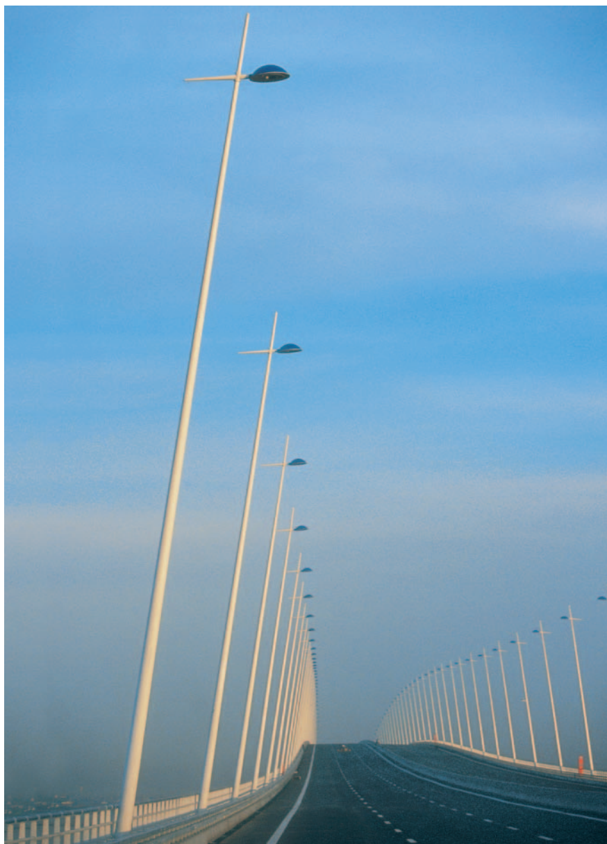
TAGE Puente Vasco de Gama – Lisboa Portugal
