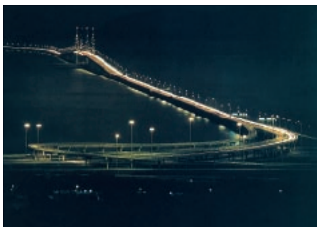
Las luminarias DZ 15 alumbran el famoso puente Penang de Malasia.
