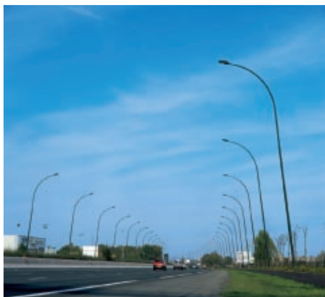
Las luminarias Onyx 3 iluminan una autopista de acceso a Budapest.
