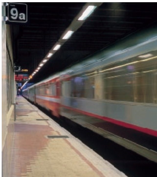
Astral, luminaria diseñada para el alumbrado de andenes de estaciones, centros comerciales, aparcamientos subterráneos, etc. Esta luminaria es disponible con una sección oval o rectangular.
