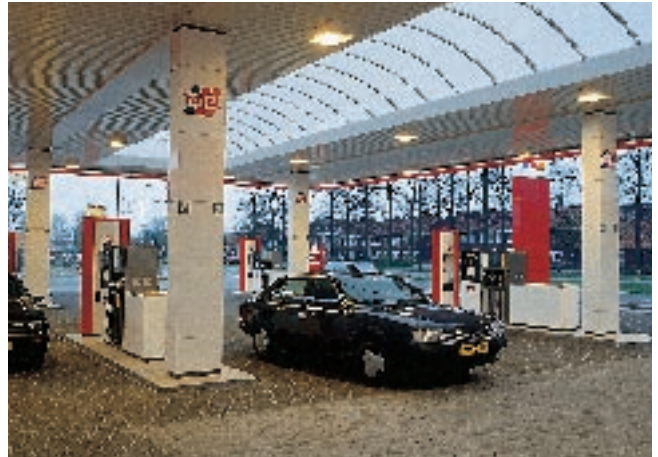
Luminarias BS con reflector simétrico (en el medio) y asimétrico (en los lados) para alumbrado uniforme en gasolineras.
