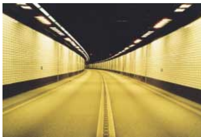
La luminaria AF4 ha sido diseñada específicamente para las aplicaciones en contra flujo y en flujo dirigido en el sentido de la circulación.
