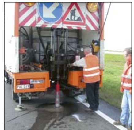
La toma de muestras de pavimento in situ constituye una operación destructiva y costosa
