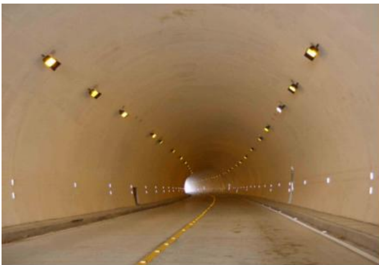
Iluminación de túnel de 650 metros, dos sentidos de circulación.
