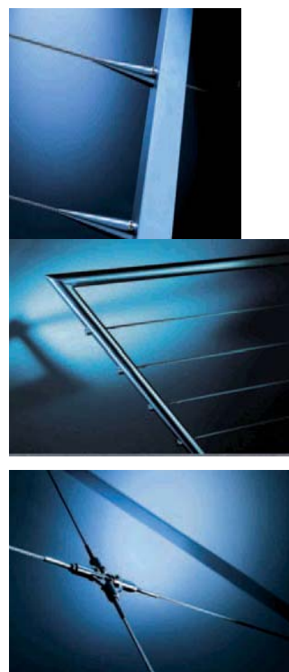
Fachada edificio con malla.
