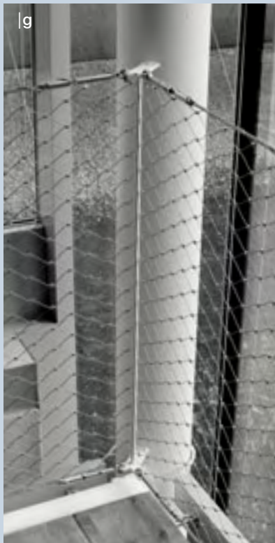
a-i Randrohre und Befestigungen | Perimeter tubes and fixing points | Tubes périphériques et fixations
