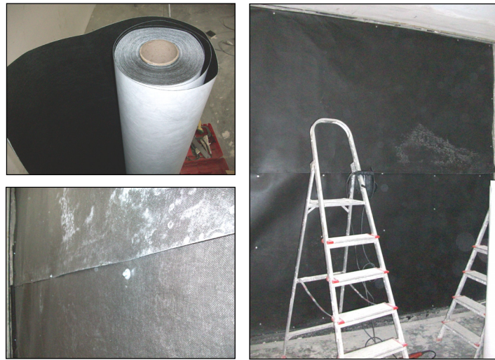
Imágenes 19, 20 y 21 Lámina Tyvek y su colocación
