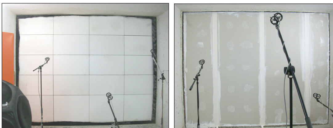
Imágenes 47 y 48 Ambas caras del cerramiento terminado y preparado para ensayo
