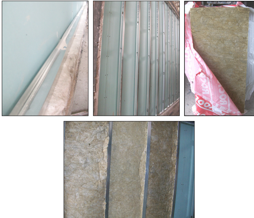
Imágenes 34, 35, 36 y 37 Estructura autoportante y colocación de la lana de roca
