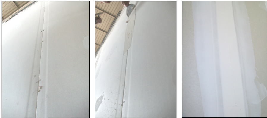
Imágenes 41, 42 y 43 Sellado de juntas entre PYL (sólo en segunda capa de PYL)
