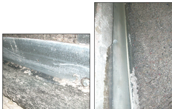
Imágenes 17 y 18 Sellado entre estructura y marco portamuestras
