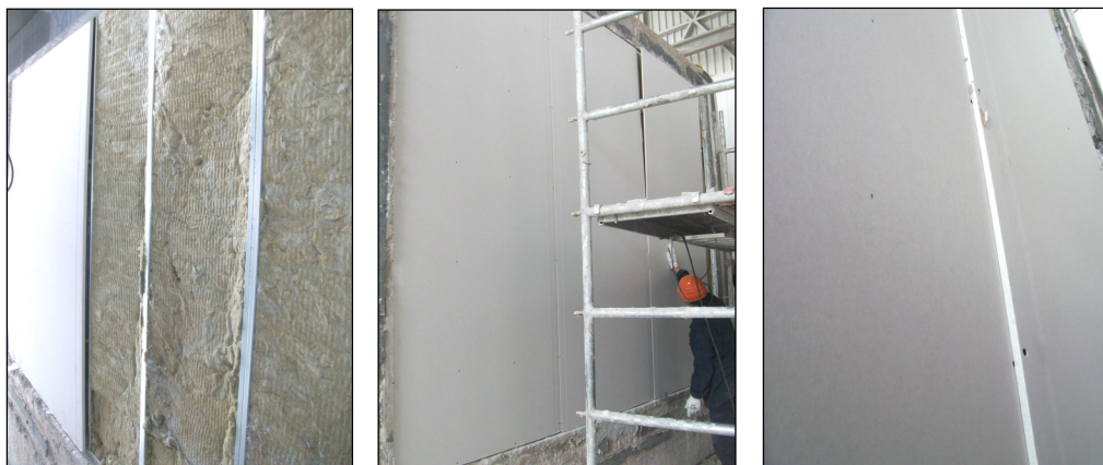
Imágenes 38, 39 y 40 Colocación de las PYL
