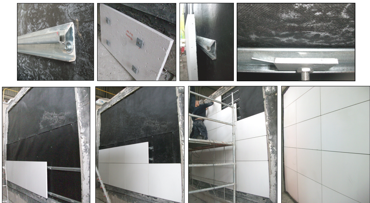
Imágenes 22, 23, 24, 25 ,26, 27, 28 y 29 Perfil Z, Panel \Omega Z y su instalación
