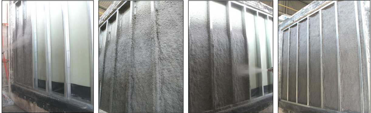
Imágenes 13, 14, 15 y 16 Aplicación del proyectado de celulosa
