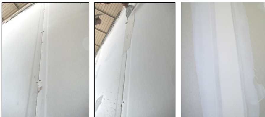
Imágenes 38, 39 y 40 Sellado de juntas entre PYL (sólo en segunda capa de PYL)
