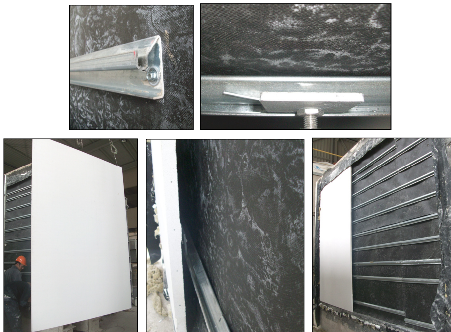
Imágenes 22, 23, 24, 25 y 26 Perfil Z, Panel \Omega Z y su instalación
