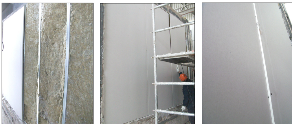
Imágenes 35, 36 y 37 Colocación de las PYL
