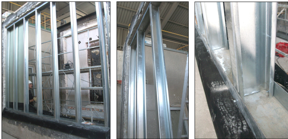
Imágenes 3, 4, 5, 6 y 7 Construcción de la estructura autoportante en el marco portamuestras
