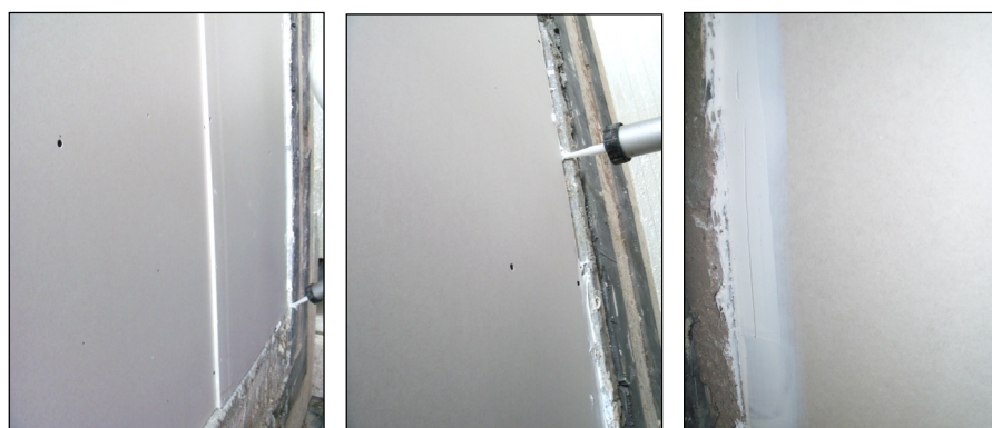
Imágenes 41, 42 y 43 Sellado entre PYL y marco portamuestras (en ambas capas de PYL)
