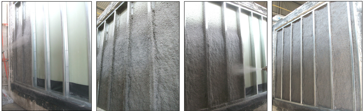
Imágenes 13, 14, 15 y 16 Aplicación del proyectado de celulosa
