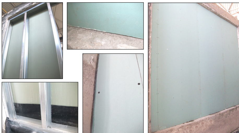
Imágenes 8, 9, 10, 11 y 12 Instalación de la PYL antihumedad
