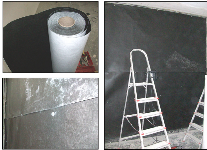
Imágenes 19, 20 y 21 Lámina Tyvek y su colocación
