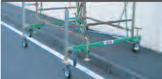
Nivelador telescópico con rueda
