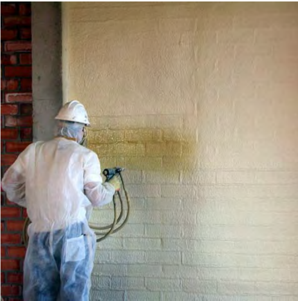
Proceso de proyección de poliuretano
