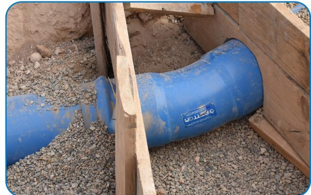
**15** Se recomienda el uso de juntas de caucho de etileno propileno dieno (EPDM ), Neopreno, geotextil... entre el tubo y el hormigón para dar cierta protección al accesorio frente a esfuerzos cortantes como consecuencia de la tracción del hormigón del macizo de anclaje.
