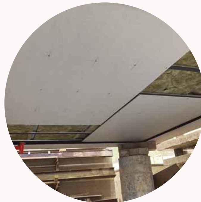
1. Forjado 2. Amortiguador F. Rapid Goma/47DS 3. Perfilera de techo suspendido 4. Lana mineral URSA TERRA Plus 32 T0003 5. Placa de yeso laminado 6. Membrana acústica M.A.D. 4
