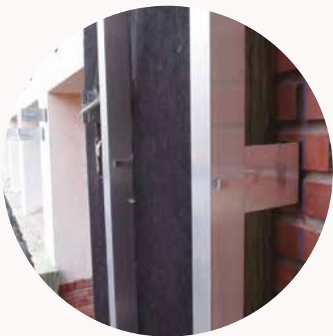
Rehabilitación con fachada ventilada en Miranda de Ebro, Ayuntamiento de Miranda de Ebro
