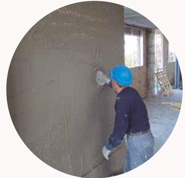
Ver en el DIT la proporción de agua indicada por el fabricante. **La mezcla se prepara mecánicamente** en batidora poco revolucionada (a unas 500 r.p.m.), o con máquina de proyectar; **desaconsejándose el amasado manual porque no garantiza un óptimo mezclado**. Mezcladores de alta velocidad (superior a 500 r.p.m.), pueden producir la oclusión de una proporción importante de aire en el material que modifica sus prestaciones. Ver en el DIT las condiciones de amasado.
