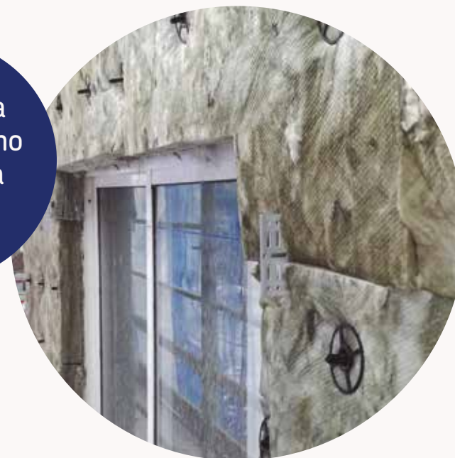
Rehabilitación integral en Donostia, Kursaal Rehabilitaciones.
